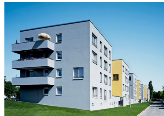
Radikaler Umbau in der einstigen Plattenbaustadt Leinefelde: Aus dem 180 Meter langen Riegel entfernten die Architekten Obergeschoss und Zwischensegmente. Für die so entstandenen Wohnungen lassen sich jetzt wieder Mieter finden
